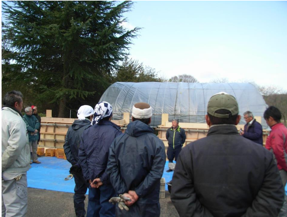
版築土塀の材料を型枠に入れて突き固める受講者
