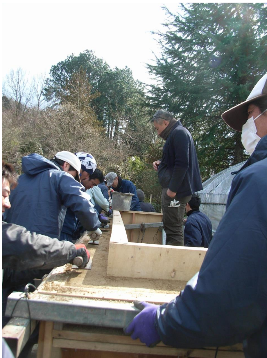
地鰻で土塀の天端を仕上げる受講者。
